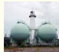
神戸灯台。工場の敷地内であって遠く憧れの存在。
